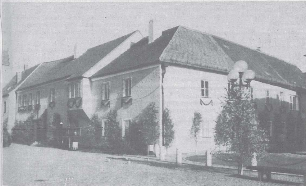
Das ehemalige Rathaus am Marktplatz 3: neben dem Museum beherbergt es auch die Räume des BRK. Nun wurde die Stadtbibliothek vom „Haus des Gastes“ in das umgebaute Obergeschoß verlegt.
